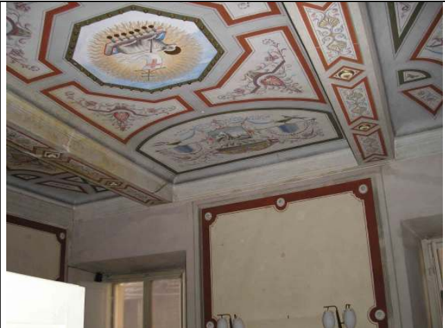
Qui la struttura è coperta e parzialmente nascosta da un rivestimento dipinto.
