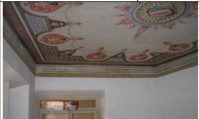
Alle volte la struttura è completamente nascosta da un controsoffitto (in questo caso dipinto). In tali casi la struttura non è accessibile da sotto salvo che sia possibile rimuovere il controsoffitto.
