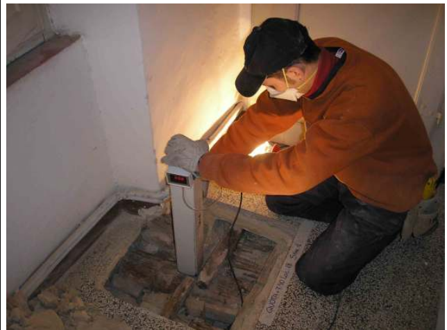
Ispezione strumentale da sopra previa rimozione localizzata del pavimento.
